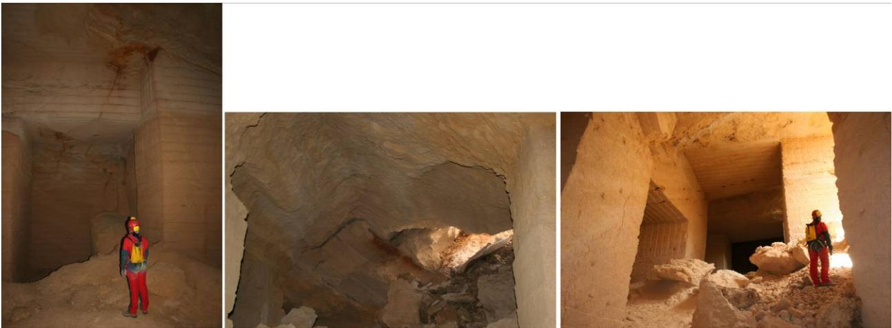
Figura 6 – Esempi di dissesti osservati nella cava sotterranea, con presenza di fratture in volta e sui pilastri, distacchi circolari in volta, e crollo totale del tetto della cava.
